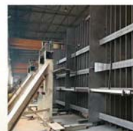
Margit híd felújítás Budapest (HU) 1800 tonna
