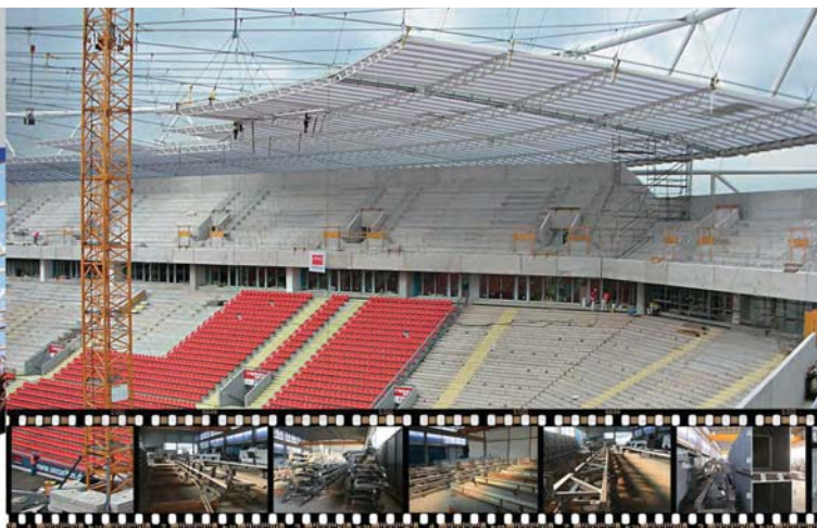
Baykrena tetőszerkezet - Leverkusen (DE)
